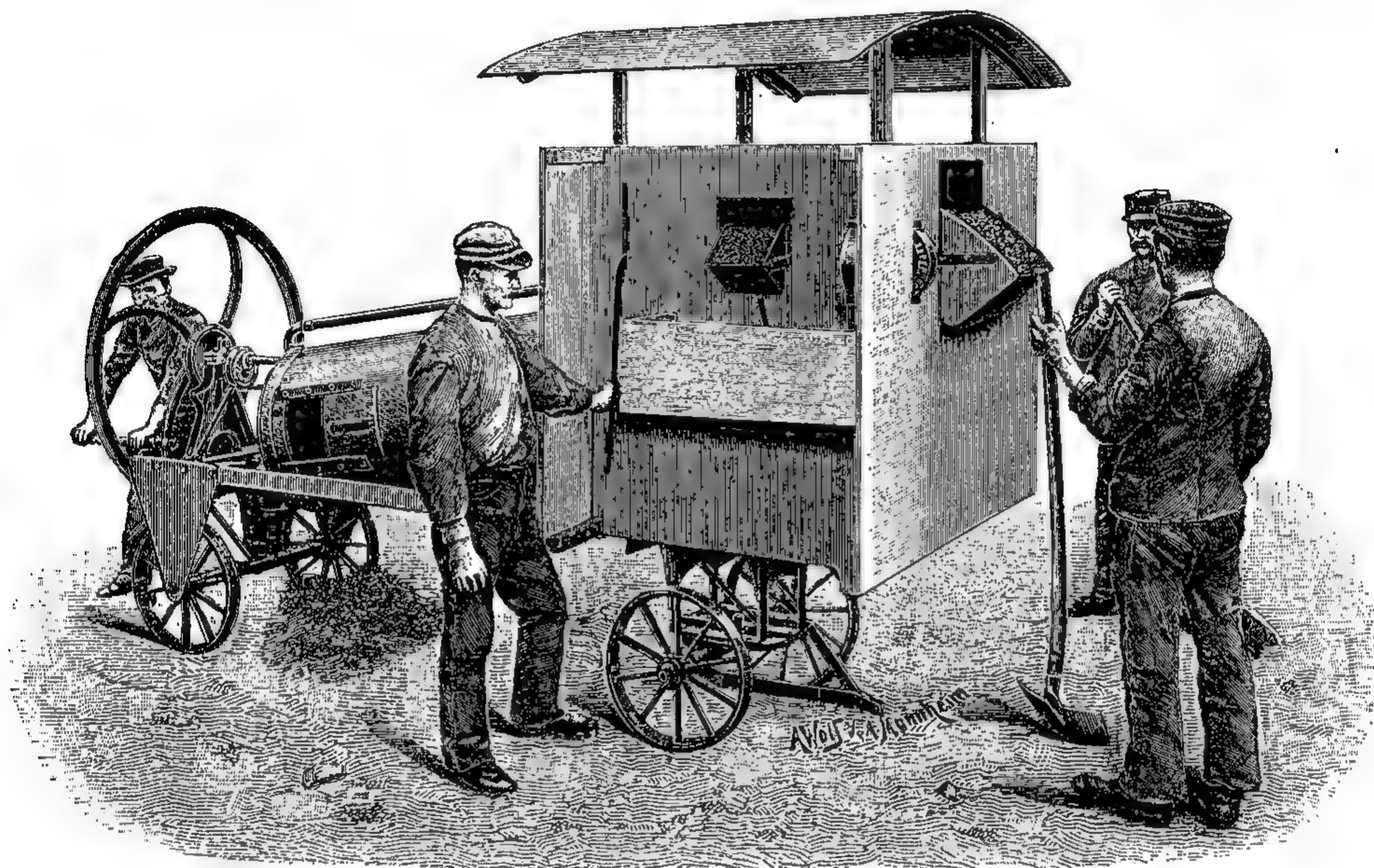
278. Бетонъера завода Гауз, Гоккель и К о въ Оберланштейнѣ.
